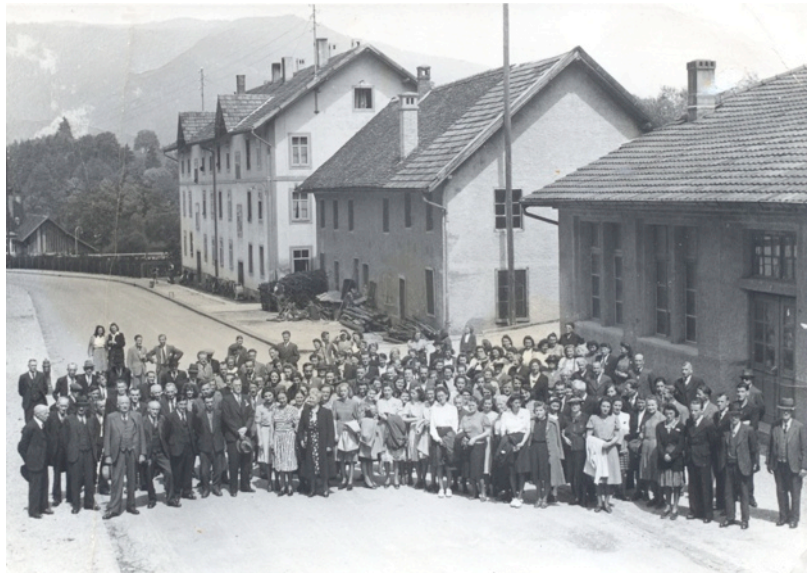
Le personnel de la verrerie vers 1950, avec en arrière-plan les appartements.(MTAH)
