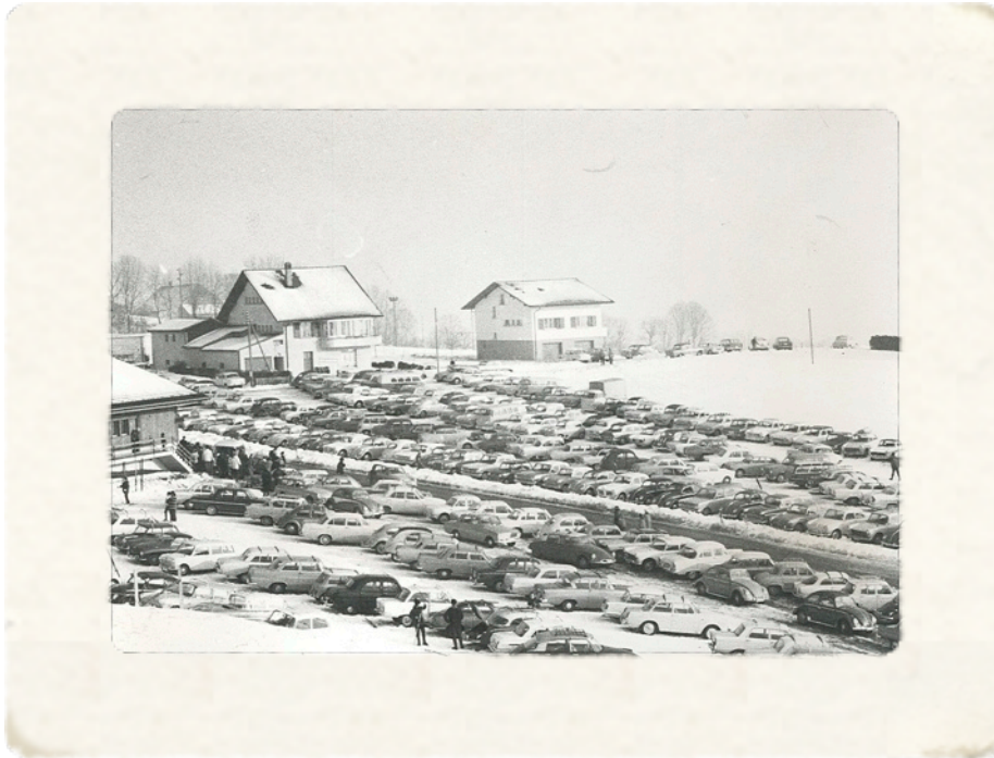
Jour d'affluence à la station du télésiège Nods-Chasseral
