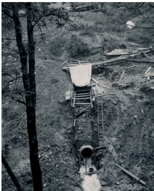
Captage d'une source et des eaux d'infiltration pour stabiliser l'éboulement
