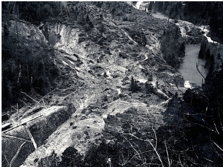
Vue générale de l'éboulement
