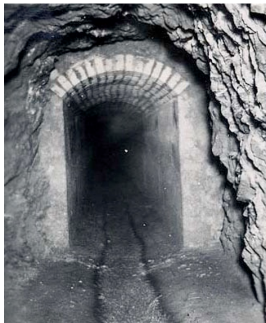
Galerie construite pour évacuer les eaux d'infiltration au pied de Graiterie
