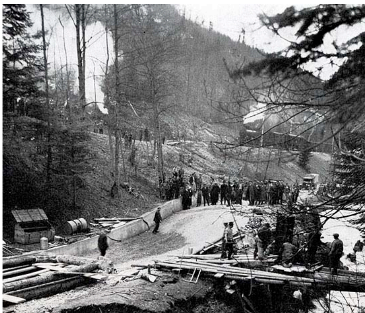
Train immobilisé, murs de soutènement lézardés
