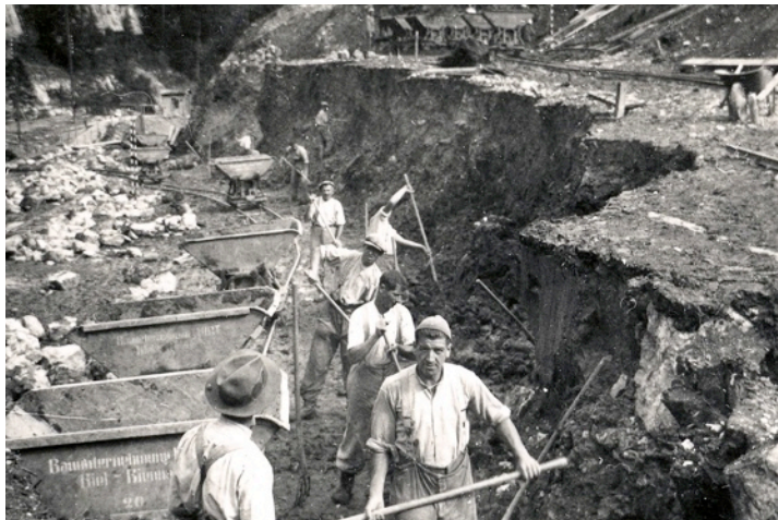
Des centaines d'ouvriers s'activent sur le chantier.
