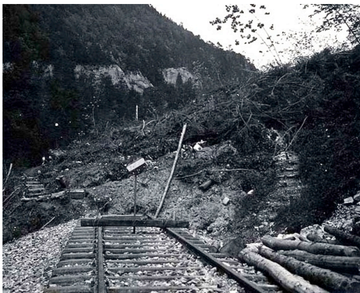
La voie ferrée est définitivement obstruée.
