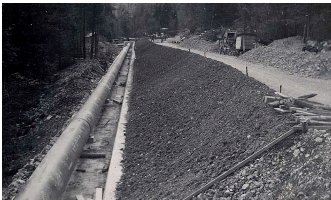
En 1938, une nouvelle conduite forcée est aménagée dans le corps de la route construite sur la rive gauche de la Birse.
