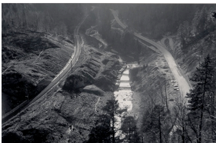
La voie ferrée sur une rive, la route sur l'autre, la Birse dans son nouveau lit au centre
