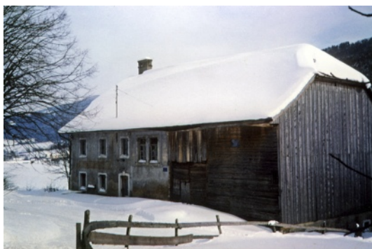
Peu avant la démolition (Collection privée)
